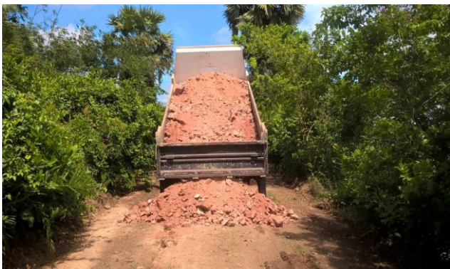
๔๐. โครงการซ่อมแซมถนนภายในตำบลขนหาด สายที่ ๑ ถนนสายต้นก้า – ต้นแค หมู่ที่ ๒
