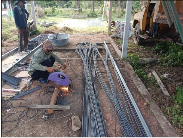
(๔๐) จัดทำฝาท่อระบายน้ำ หมู่ที่๑
