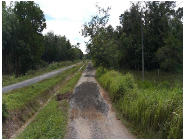
ซ่อมแซมกบหลุมบ่อถนนหินคลุกสายบ้านครูชอบ หมู่ที่ ๕
